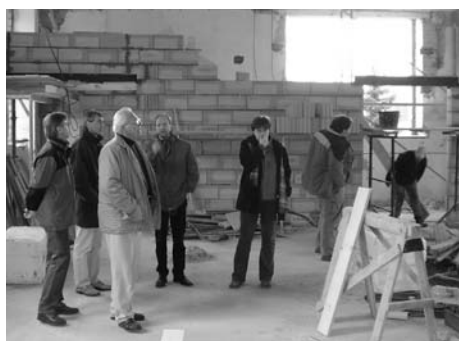
Rada města na „exkurzi“ po staveništi rekonstruované tělocvičny. ➔
