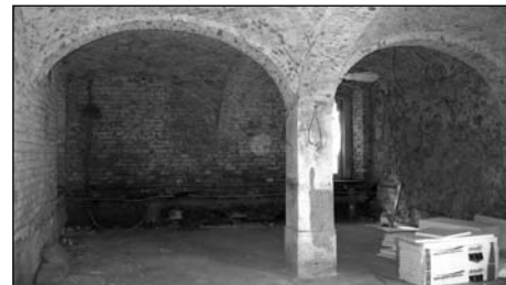
V Centru služeb je snaha zachovat část původních prvků, jako např. kamenné a cihelné klenby v přizemí.
