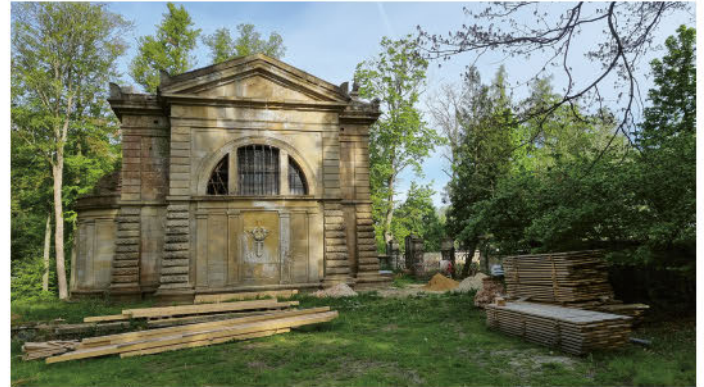
Na střeše hrobky jsou nainstalovány masivní trámy tvořící základní kostru krovu
