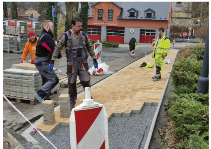
Původní asfaltový povrch ze sedmdesátých let byl podbetonován, vrstva betonu byla místy více než 20 cm
