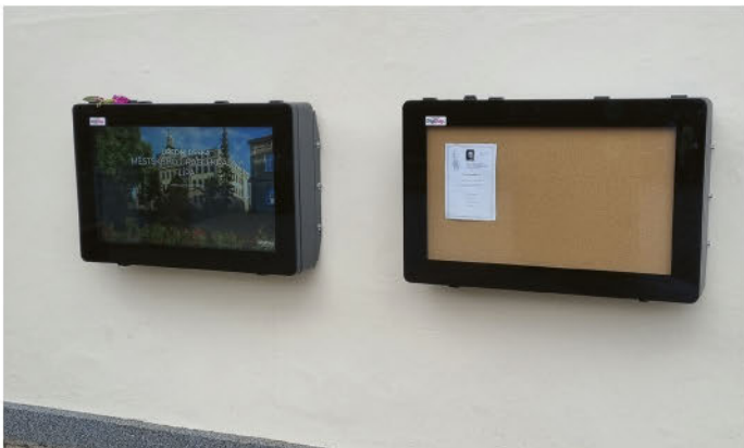
Úřední deska (vlevo) i vitrina pro občanská sdělení jsou nainstalovány v nižší pohledové výšce z důvodu dostupnosti pro imobilní osoby
