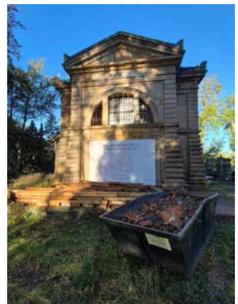
Na Dittrichově hrobce restařatoři dokončují stabilizaci kamenných prvků. V příštím týdnu tak bude možné pokračovat ve stavbě tesařských konstrukcí střešního krovu.
