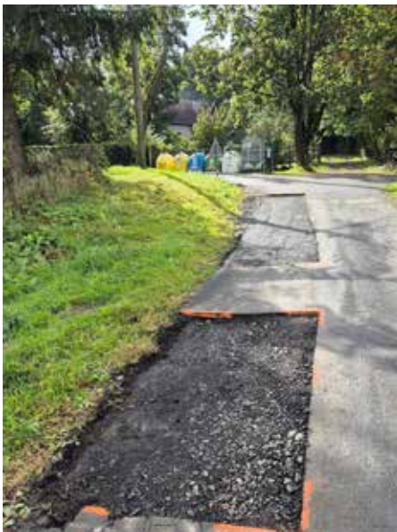
Na různých místech našeho města probíhají opravy výtluků v asfaltových površích místních komunikací.
