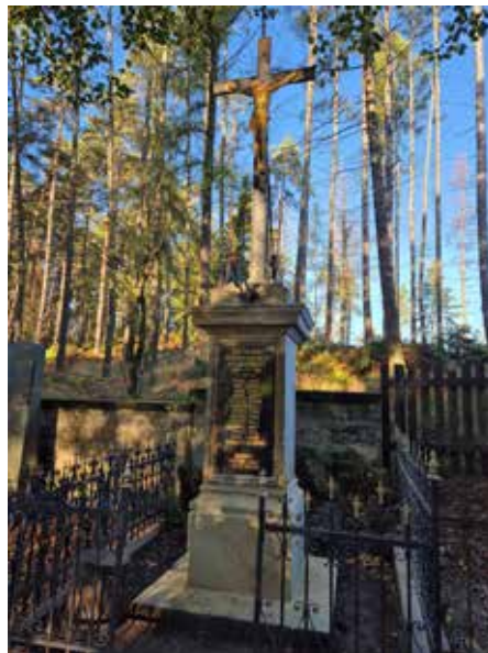
Na hřbitově v Kyjově obnovujeme památník padlým v 1. sv. válce
