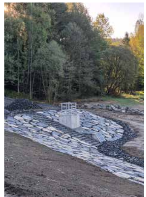
Práce na Kyjovské přehradě jdou do finále. Probíhají instalace zámečnických konstrukcí, terénní úpravy hráze a dokončovací práce na podhráží.
