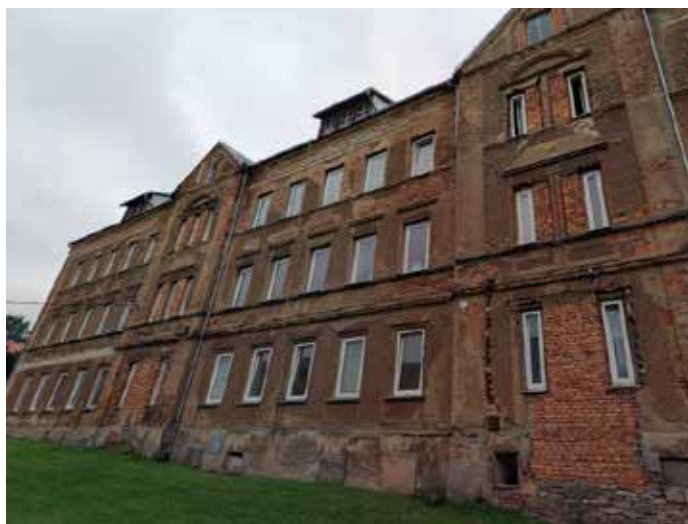
čp.564 - hlavní výrobní budova firmy Hampf. Dnes obytný dům
