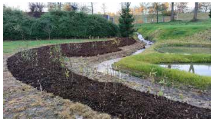
Kolem nových tůň pod rybníkem Cimrák probíhají sadovnické úpravy.
