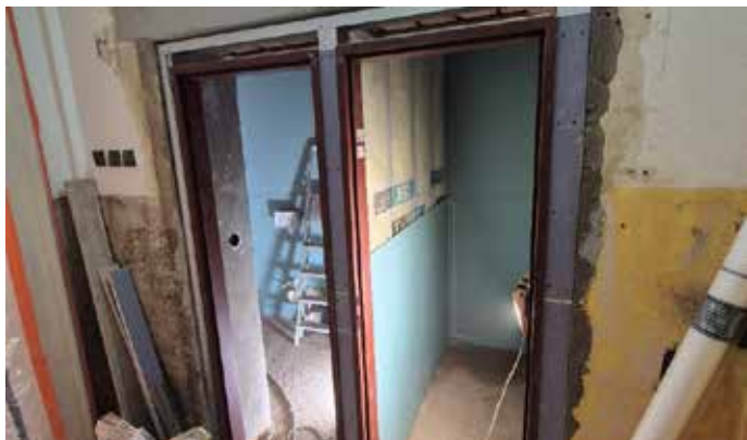
Začali jsme s budováním výtahu v objektu radnice.
