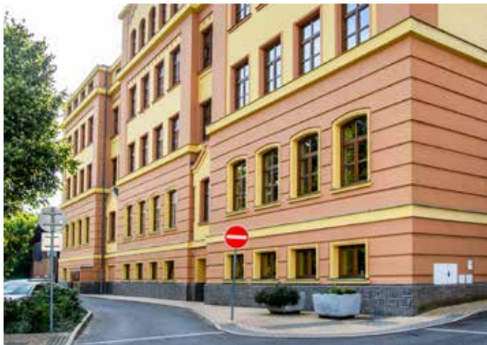
Obnovili jsme a vyčistili čelní fasádu školy.
