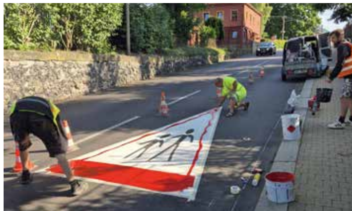
Dokončujeme doplňkové vodorovné dopravní značení u MŠ Sluníčko v Masarykové ulici.
