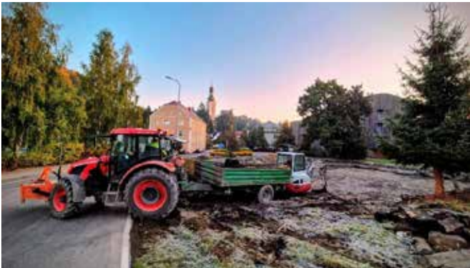
Rybníček u náměstí jsme odbahnili, odstranili jsme březové porosty a následně opravíme opevnění břehů. V rámci výstavby tůň pod Cimrákem bude upraven i nátok vody.
