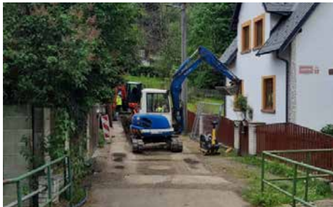
Ve Fibichově údolí pokračuje výstavba kanalizačního a vodovodního řádu, dojde i k demolici stávajícího mostu a výstavbě nového.
