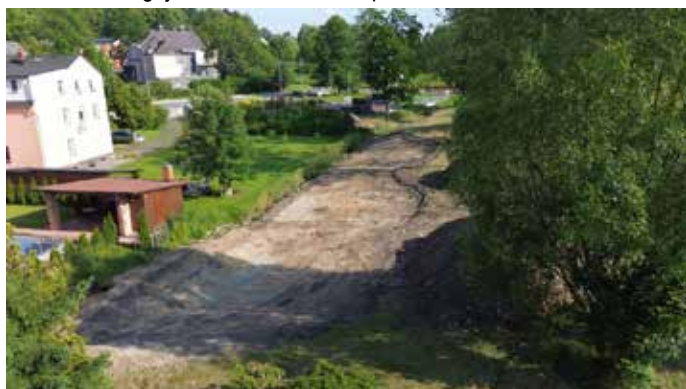
Probíhá příprava prostor pod Cimrákem v rámci projektu Land4Climate.
